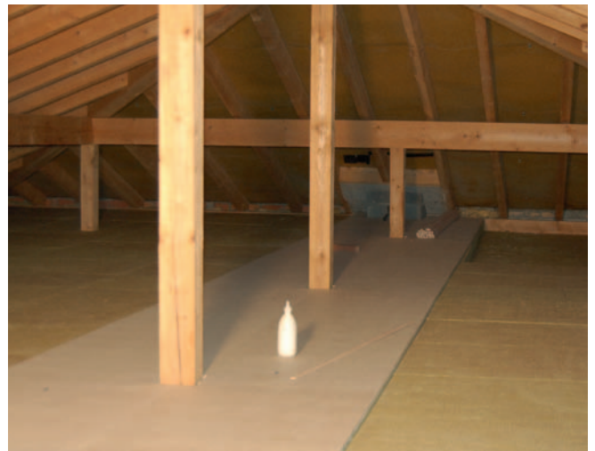
3. Der Spanplattenboden wird schwimmend auf die Dämmung verlegt.
