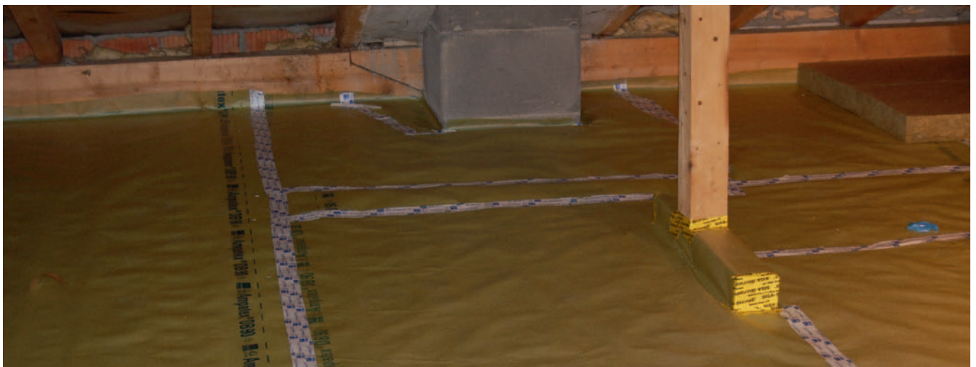
1. Die Luftdichtungsfolie (Dampfbremse) wird vollflächig verlegt. Die Folienstösse und Randanschlüsse werden luftdicht abgeklebt.
