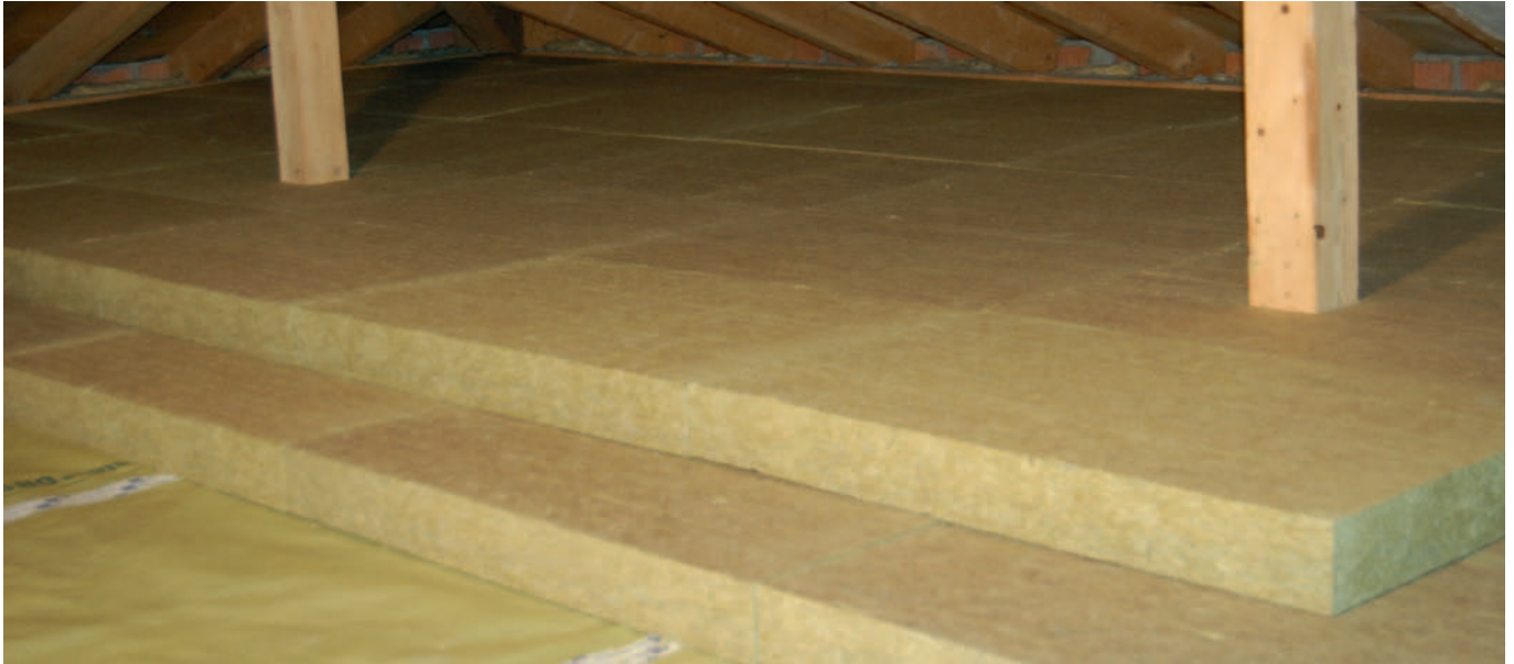
2. Die druckfeste Wärmedämmung wird vollflächig ein- oder mehrlagig verlegt. Die Platten werden präzise an angrenzende Bauteile angeschnitten.
